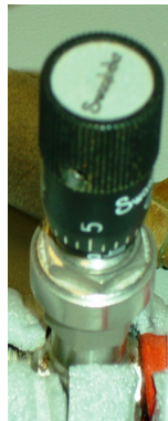
Figura D.19: Válvula de expansão do evaporador.
