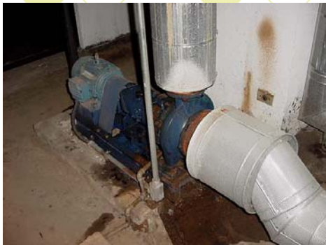
Bomba de Água Gelada
