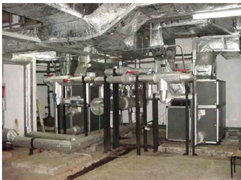
Fan-coil e dutos de água gelada
