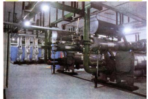
Casa de Máquinas
